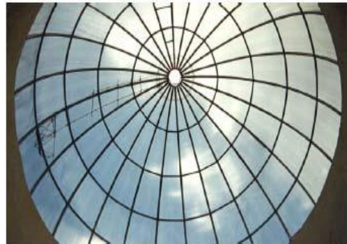
Sử dụng cửa với mái vòm FRP có kiến trúc cơ bản có thể loại trừ việc sử dụng đèn điện trong hành lang của các nhà cao tầng
